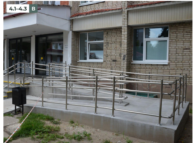
Фото 2. Зовнішній пандус: Н = 0,625 м, L = 8,71 м, середній ухил 7,17 % (поз. 4.1–4.3)
