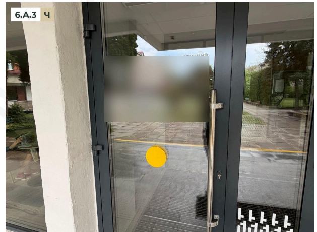
Фото 4. Маркування скляного полотна лише на висоті 1,5 м, нижній рівень відсутній (поз. 6.A.3)
