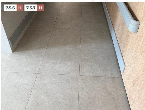
Фото 5. Внутрішній пандус: поручень на одній висоті 0,9 м, контрастного маркування немає (поз. 7.5.6, 7.5.7)
